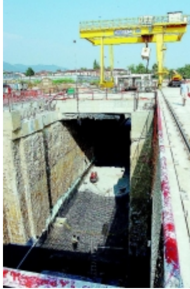
I cantieri del metrobus: una delle grandi infrastrutture bresciane
